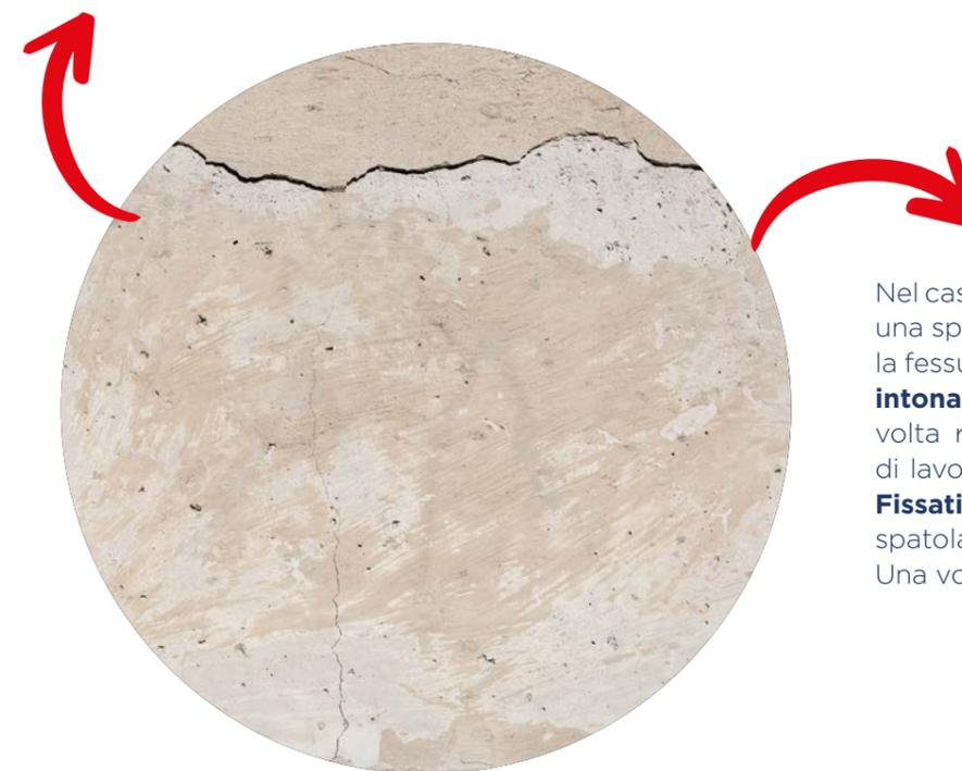
Nel caso di **crepe** è consigliato passare una spatola per allargare leggermente la fessura e rimuovere **tutta la parte di intonaco superficiale non salda**, una volta rimossa la polvere ed i residui di lavorazione, bagnare la traccia con **Fissativo Murale** e stuccare con una spatola livellando al massimo. Una volta asciutto carteggiare.
